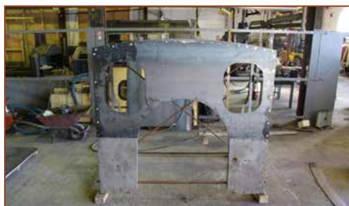
Førerhuset er ved at få ny beklædning
